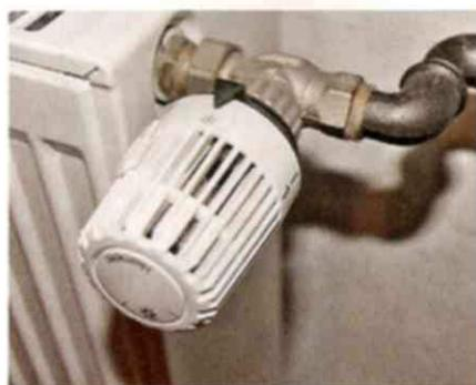
Beim Austausch eines Stahlradiators gegen einen Plattenheizkörper müssen oft die Abstände ausgeglichen werden.
